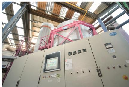
Mit der modernen Abluft-Reinigungsanlage können die vorab entstandenen Emissionen bei der Gebinde-Reinigung, der Verdünner-und Anstrichstoff-Herstellung sowie dem Lösemittel-Recycling eliminiert werden.
