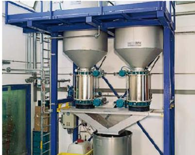
Die abgebildete Installation ist ein Teil des umfassenden Abwasser-Reinigungs-systems in den Produktionswerken Gossau und Arnegg. Schmutz und Schad-stoffe werden in einem dreistufigen Reinigungsprozess separiert und fachge-recht entsorgt.
