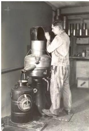
Sorgfalt wird bei KABE seit Beginn gross geschrieben: Der Mitarbeiter filtert und zentrifugiert Verunreinigungen und Pigmentkörner aus dem Industrielack. (Bild: Karl Bubenhofer AG)
